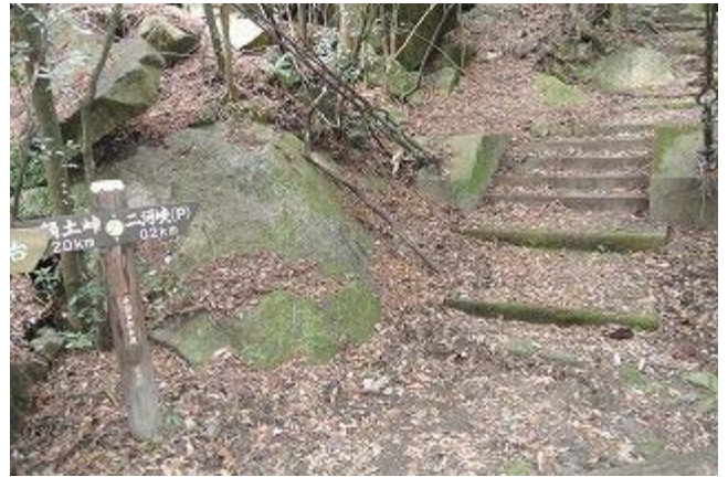
吊り橋の手前 落ち葉撤去前
