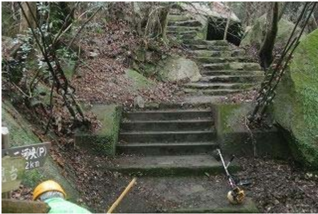
中国自然歩道 二河峡吊り橋の右側 落ち葉撤去後
