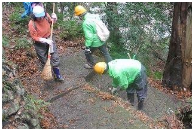
二河峡 観音堂参道整備中
