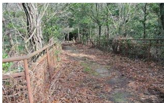
焼山平谷線 隧道上の草刈後
