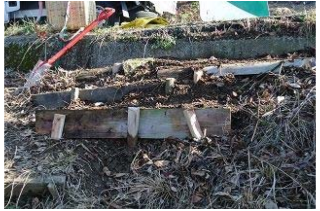
灰ヶ峰 山頂の手前 階段の補修
