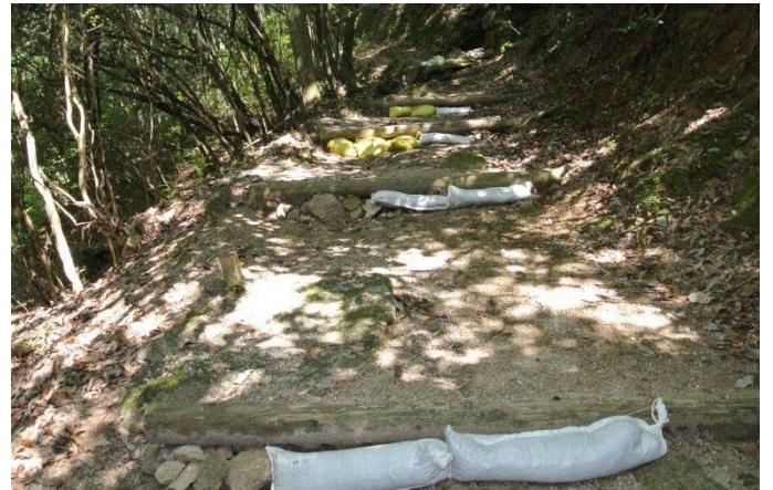
滝からの水が柵から溢れて路を削ったので土嚢を使って土砂の流れを防止
