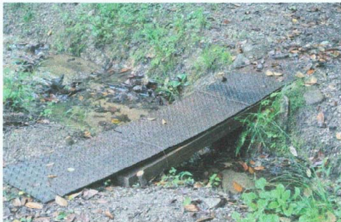
鉄板の下に廃材垂木 8 本で架橋完成 6/26 福馬氏
