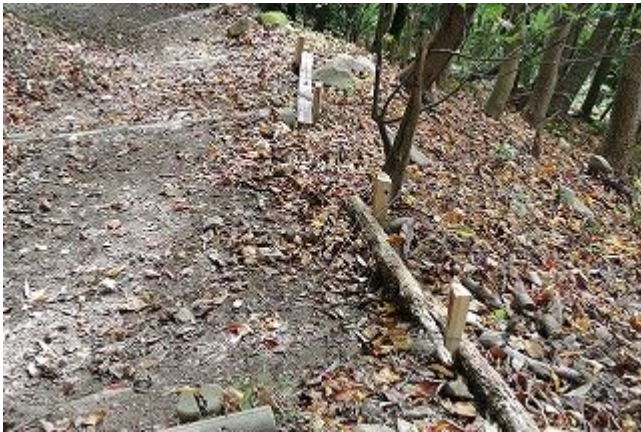
廃材垂木路肩に固定前 正面登山路
