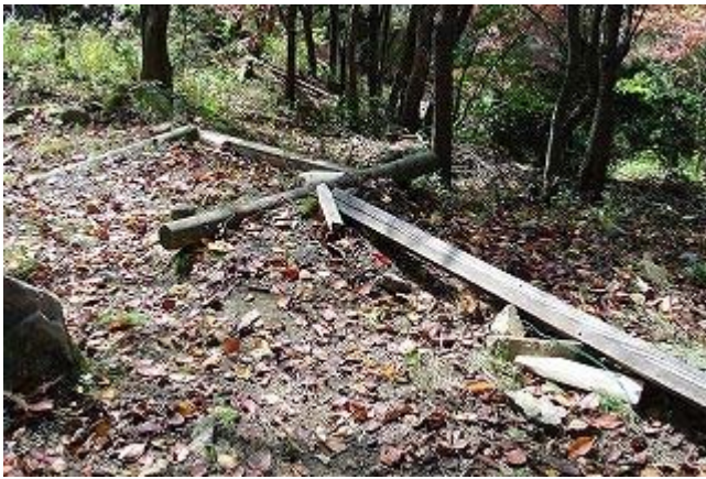
廃材垂木4本を1組 路肩補強材固定前
