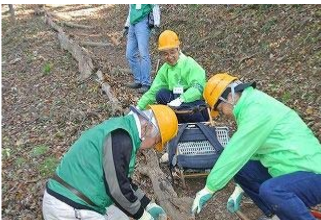
番線で杭と廃材垂木を固定中の広兼・成田・矢吹
