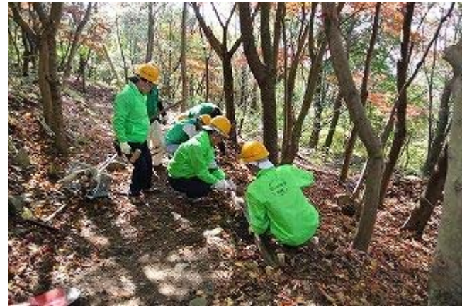
路肩に廃材垂木を設置中
