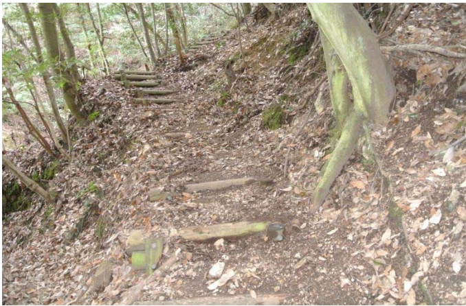
滝壺に降りる階段 落ち葉を撤去後
