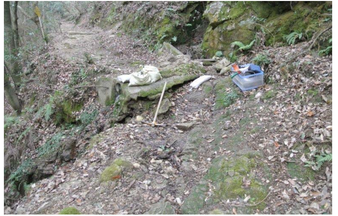
崖からの水を止める樹から溢れて路を削る悪い箇所
