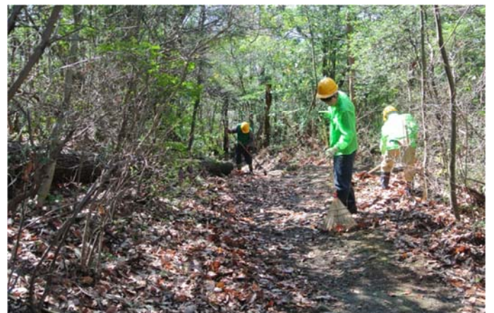
鍬・鉄製熊手で落ち葉を撤去中
