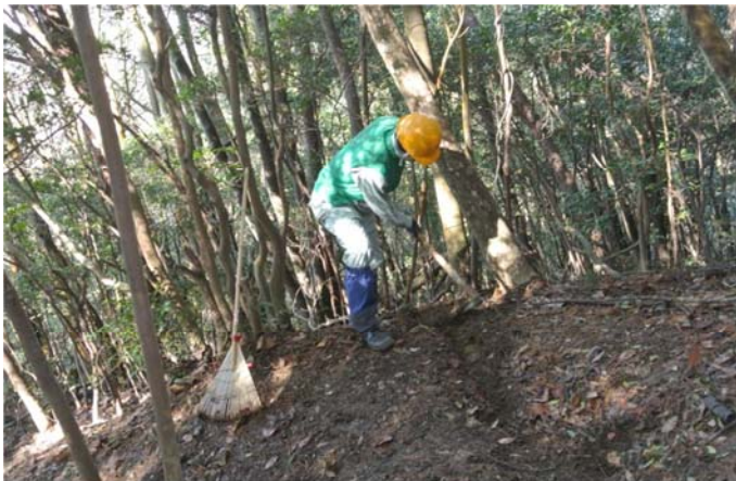
水路を掘り下げ中 (田中)
