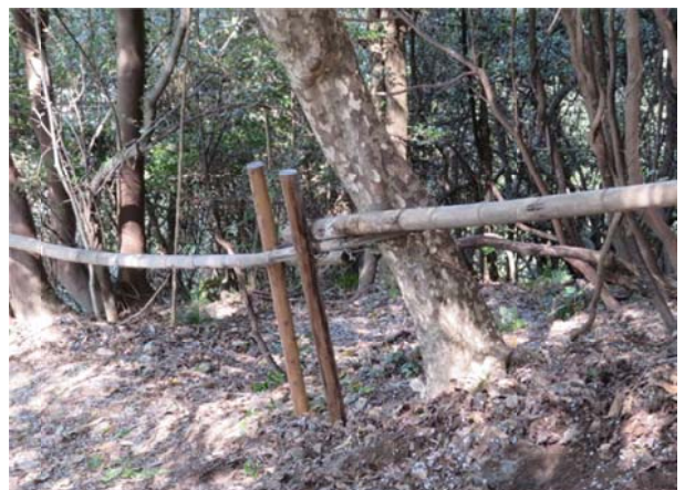
4年前の手すりの支柱が朽ちたので取り替えた
