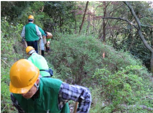
七曲りの登山路山側に水路を掘り込み中
