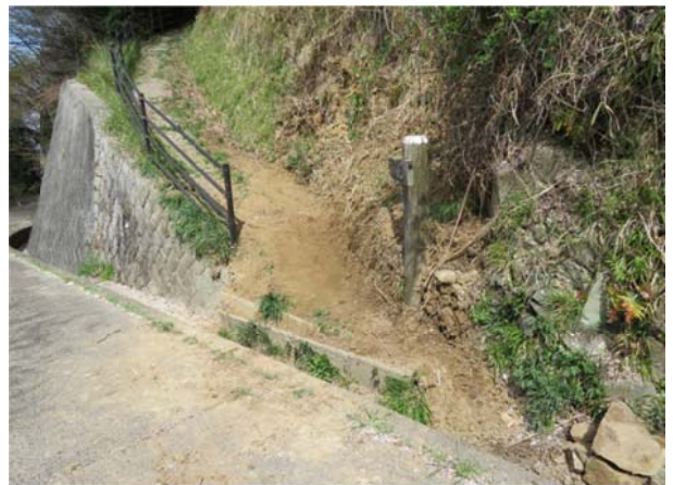
一輪車を駆使して 土砂・石を運搬した 正面登山路
