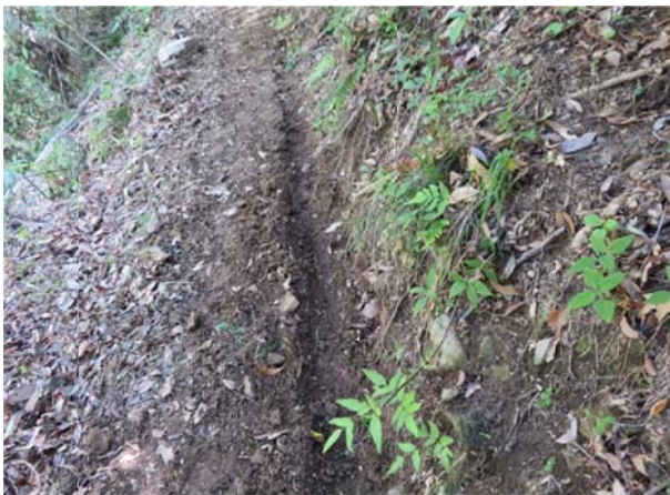
斜めになった路 水路を掘り込み後
