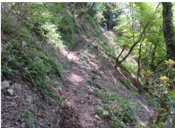
路が斜めで歩きづらいので、水平な路に掘り込む
