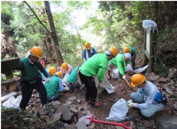
土嚢袋に岩・石を詰めているところ
