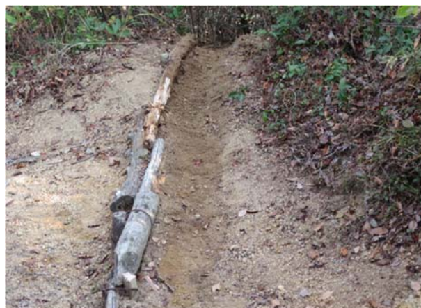
枯れ木も活用して水路づくり
