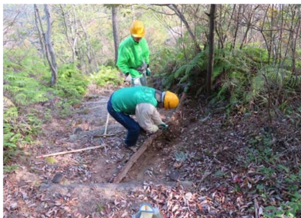
廃材4本組を使って水路づくり
