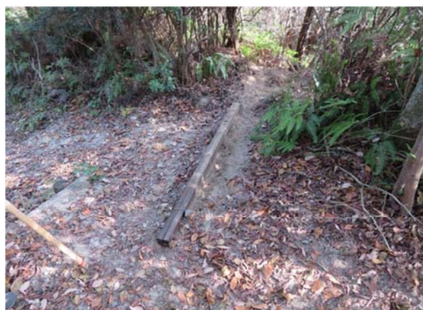
矢吹氏と廃材を4本組にした垂木で、水路作り
