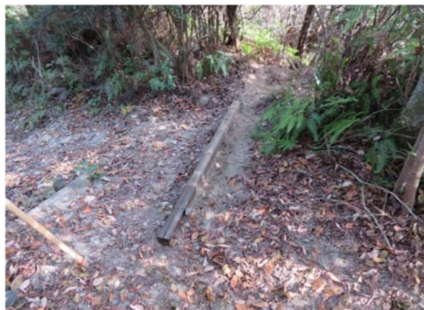
廃材垂木 4本組で水路を作る
