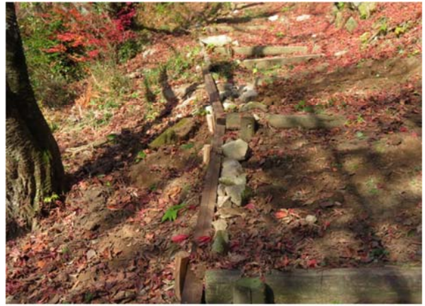
路肩補強後の正面登山路
