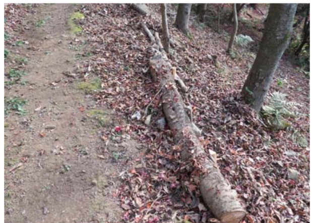
歩道下から引き上げ後 枯れ桜を路肩に活用
