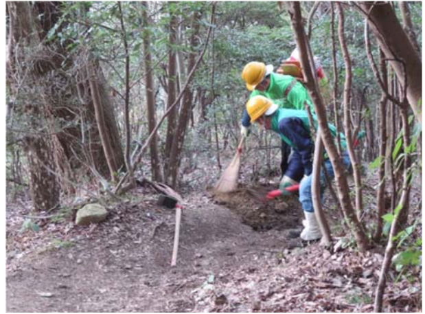
水路を作成中
