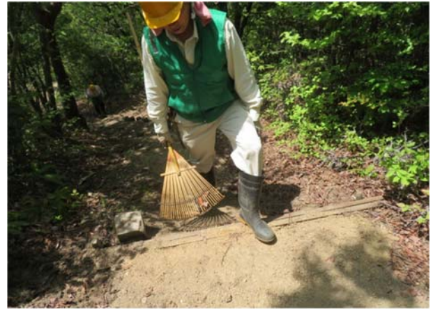
廃材垂木で階段を新設
