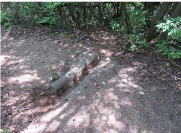
横断溝の清掃後
