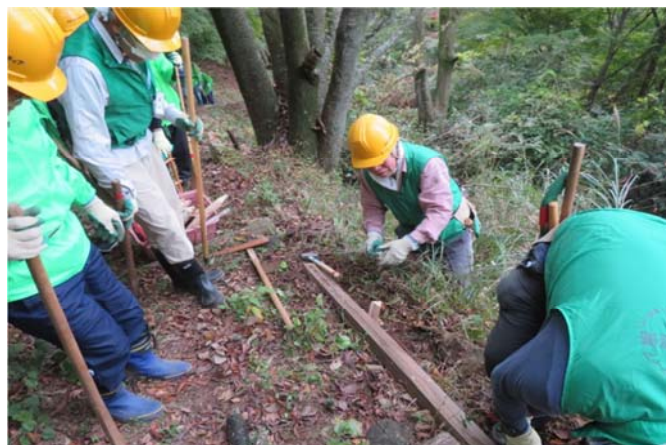
路肩に廃材設置中
