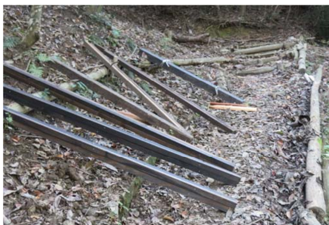
3. 5×3.5長さ2mを4本ネジクギで1組に設置前
