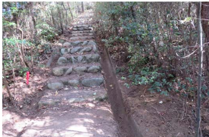
長年の土砂を撤去後の側溝
