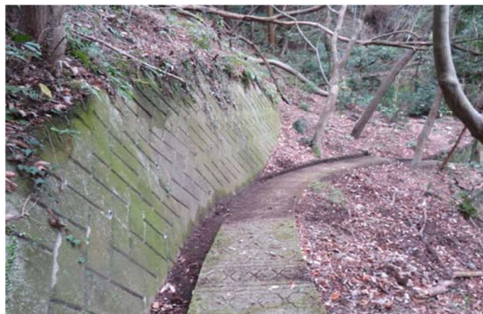
側溝の清掃後
