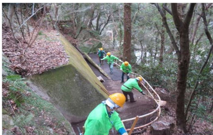
皆でこびり付いた落ち葉を撤去中
