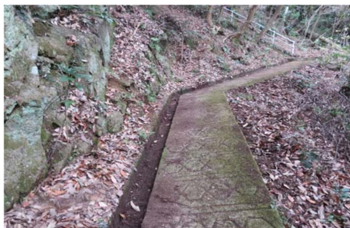
側溝の落ち葉・土砂を撤去後
