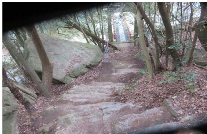
正面 奥は吊り橋 清掃後
