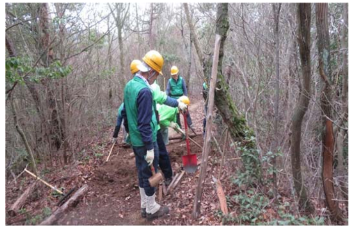
猪に壊されないように大きい横断溝作製中
