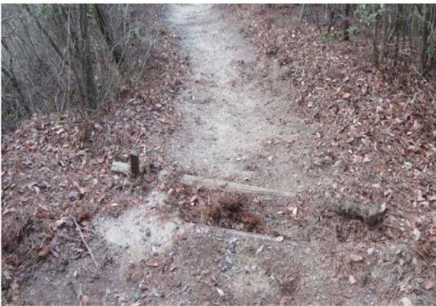
横断溝 すっかり埋まってしまった (清掃前)
