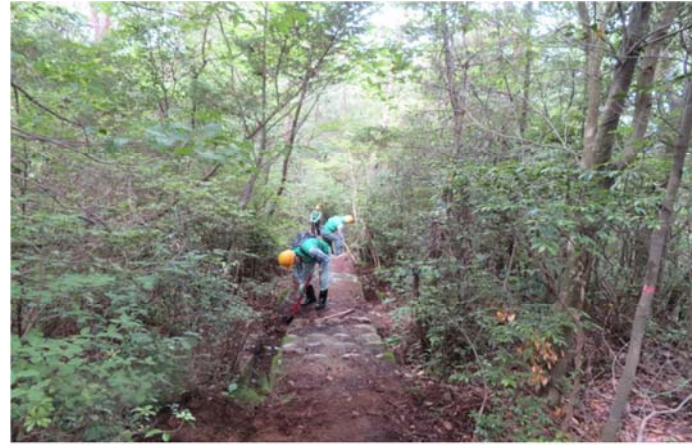
遊歩道の側溝を清掃中
