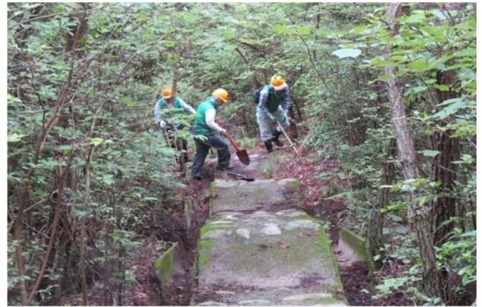
遊歩道の側溝を清掃中の広兼氏ら3人
