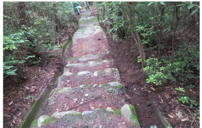
清掃後の側溝 (側溝の土砂・石を撤去)
