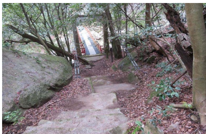
吊り橋を向かいに綺麗に清掃後
