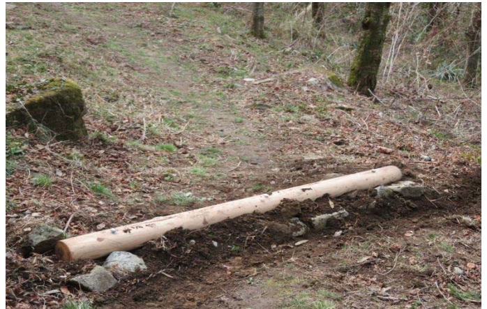
水路に丸太を使って水流を抑え込む
