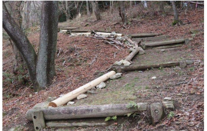
路肩が弱い所へ丸太を使用
