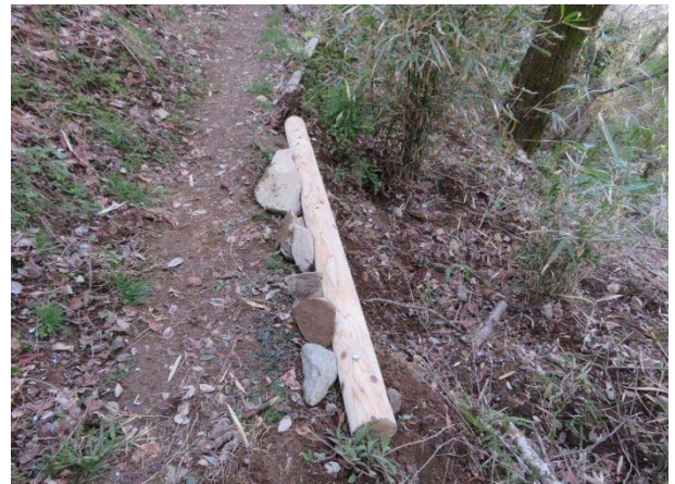
路肩の崩れている箇所へ檜丸太を設置中 杭3本
