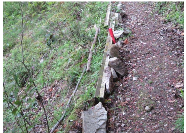
不安定な路肩 石を使って補強中
