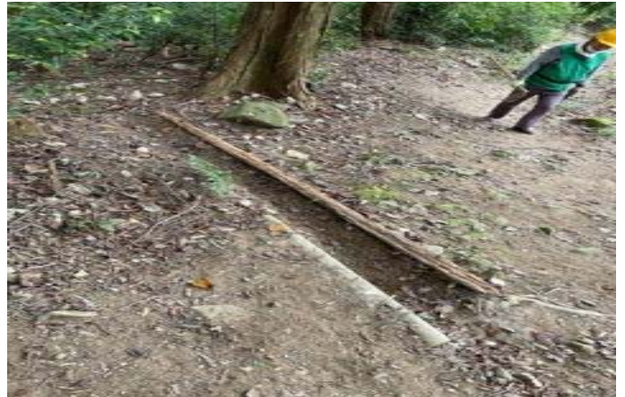
詰まりかけた横断溝の清掃後
