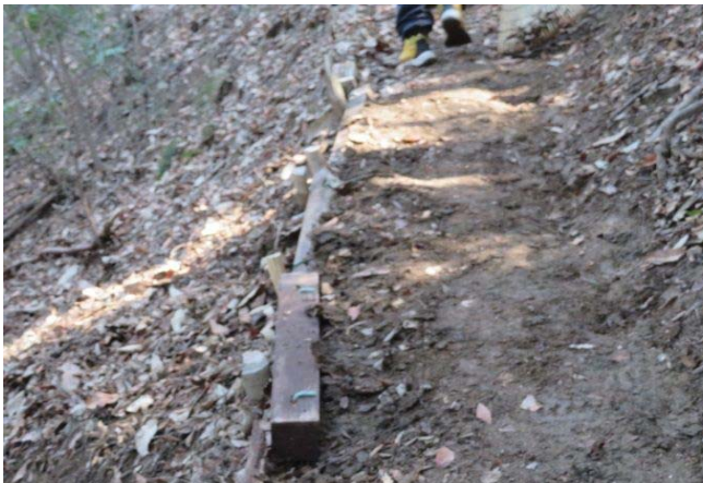
持参の角材 異形鉄筋をボルトにして打ちつけ
