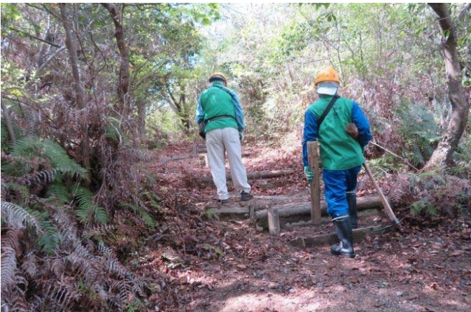
資材と道具を運搬中 ブロアで落葉撤去中
