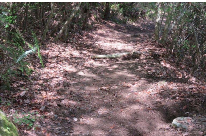
ブロアで落ち葉を飛ばして歩道を整備した
