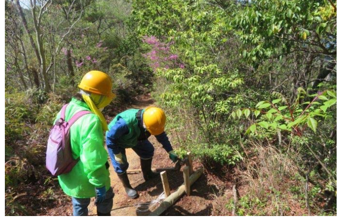
水流を抑制するために杭を取り付け中
