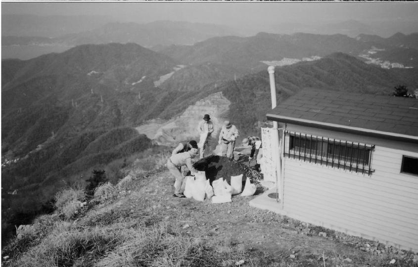
登山路階段が酷く窪み、大変歩き難いので、バラスを提供してもらって、ダンプカーで下ろした、バラスを土嚢に詰替えている所
