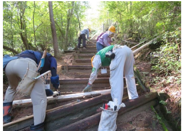
階段に半丸太設置中
