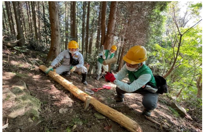
階段を丸太で増設中
