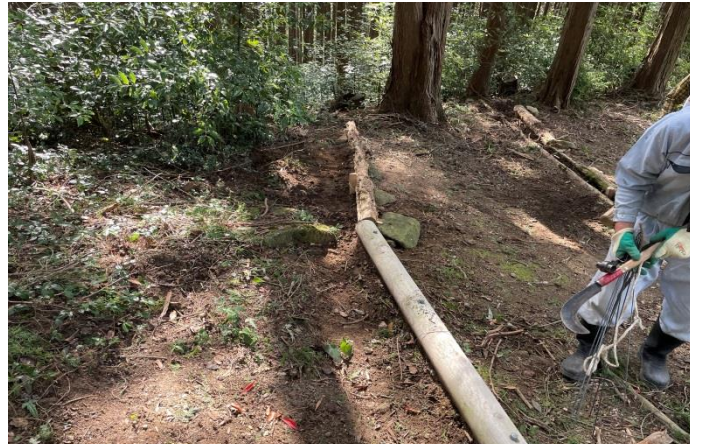
横断溝の新設
