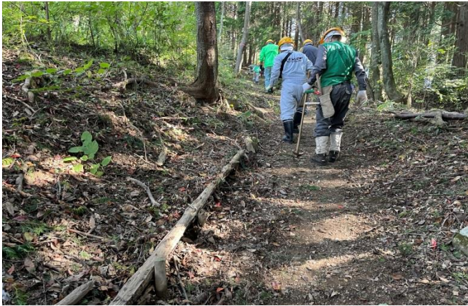
路肩補強後 登山路 熊手とブローアで整備後
