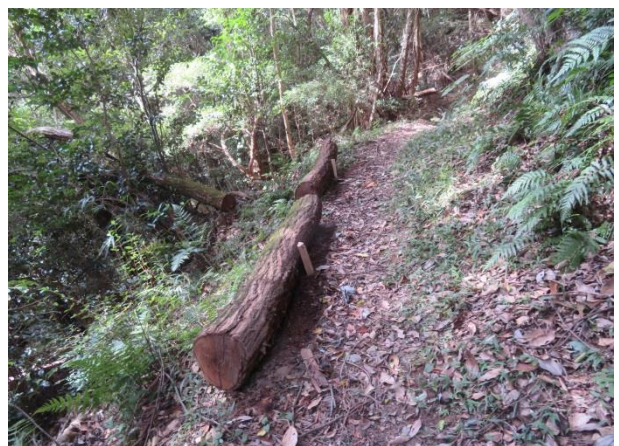
崩落した登山路 プロの手で切断した丸太
