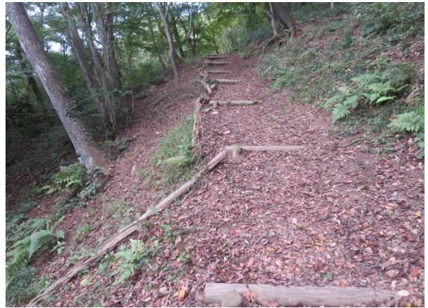
路肩の補強が坂へ転がってる
