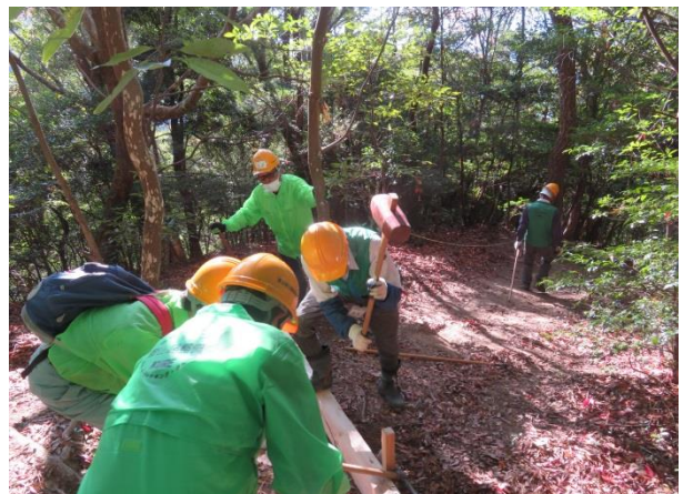
角材で水路を作製中
