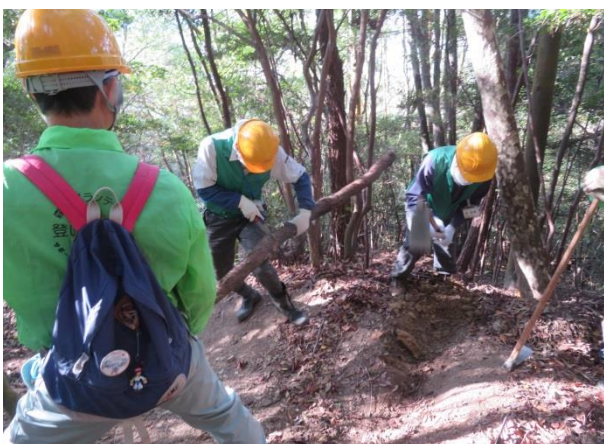
水路を掘り込み中
