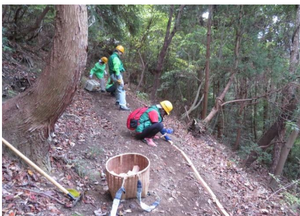
弱い路肩に廃材(20cm)垂木を打ちつけた
