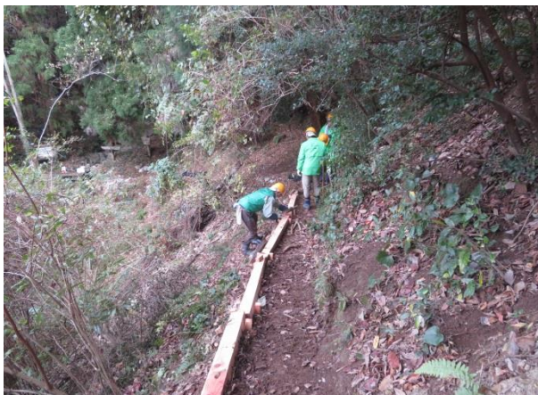
崩落防止に角材を設置
