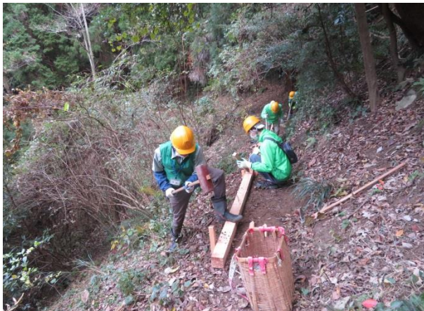
銀明水 崩落する登山路の補修
