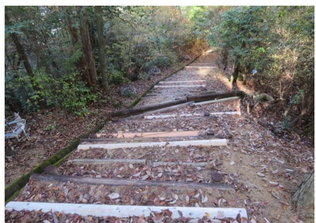
大庭山角材設置 蹴上がりの縮小のため
