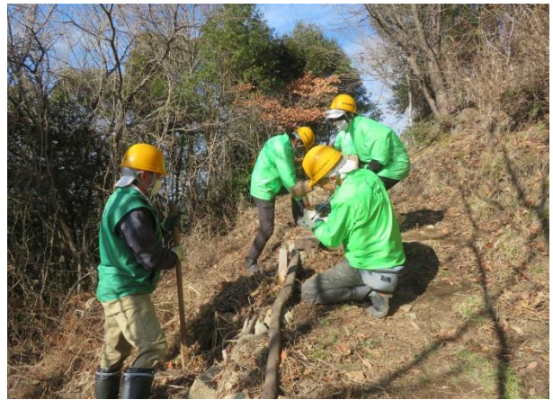
路肩の補強中
