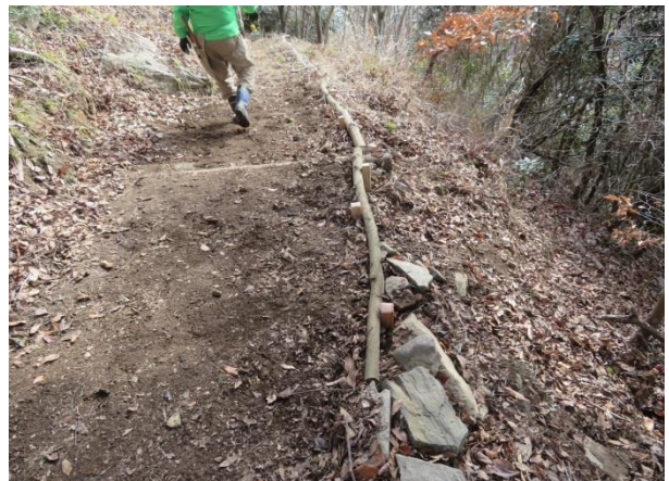
路肩補強に杭・石を使用
