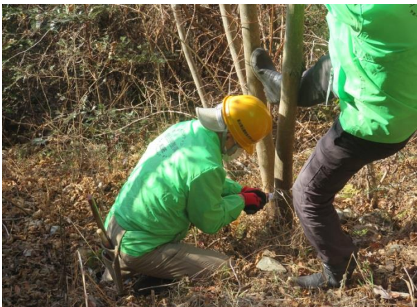
路肩補強のため現地で調達
