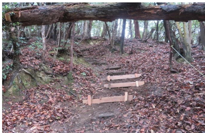
滑り易い個所に角材で階段を新設
