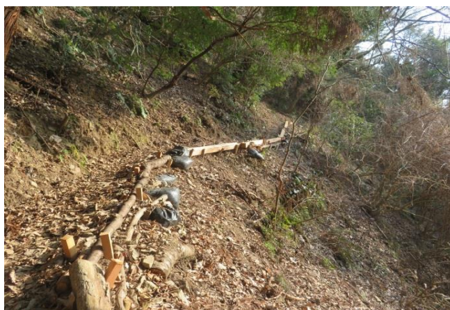
銀明水付近 角材で路肩を補強後
