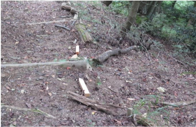
路肩 補強のため角材設置予定地
