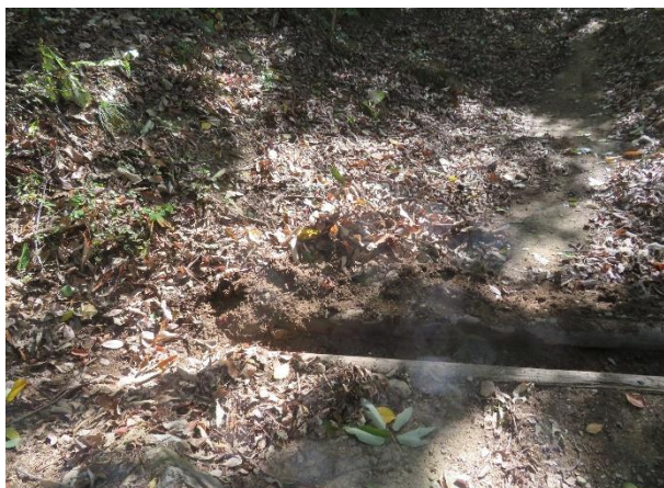
横断溝の掘り込み後の状況
