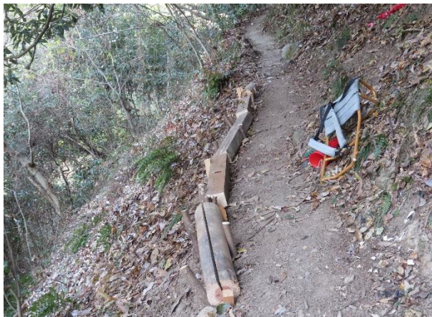
路肩に角材6本設置状況
