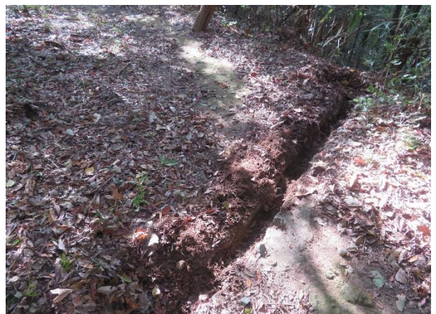
横断溝の掘り込み後状況
