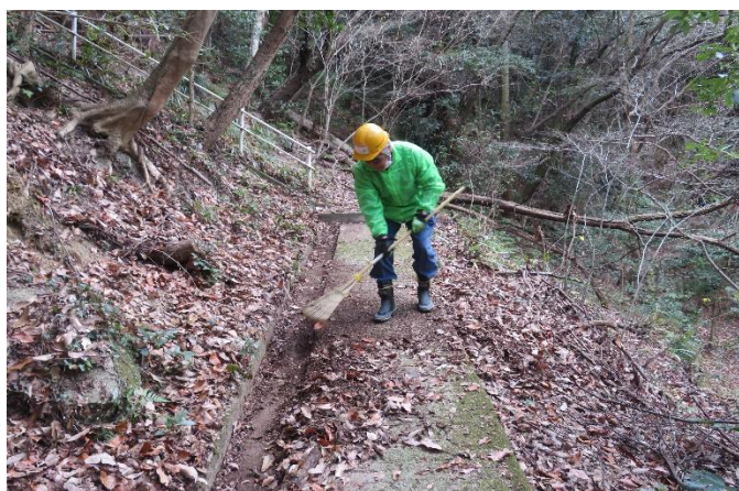
側溝を清掃中、
