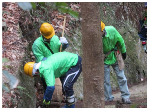
側溝の落ち葉、土砂撤去中
