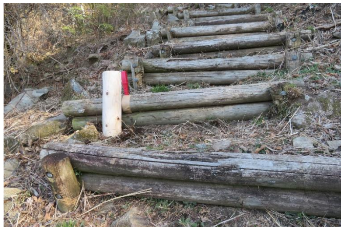
階段を止めた杭が腐ってぐらつくので、固定用杭を打った
