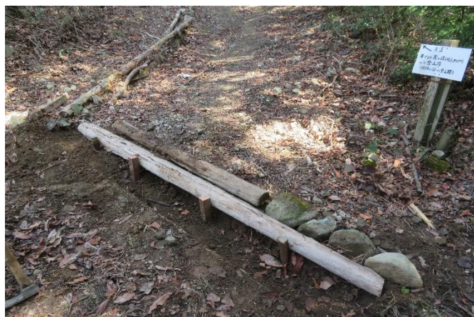
手入れ後の横断溝
