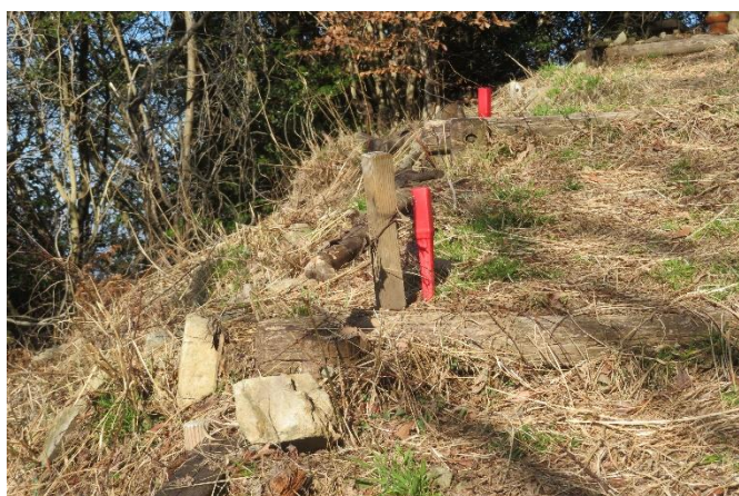
番線を使って固定した路肩（手入れ後）
