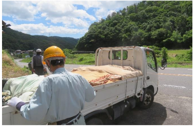
多くの木材を頂き、トラックの荷台がいっぱいになった。
