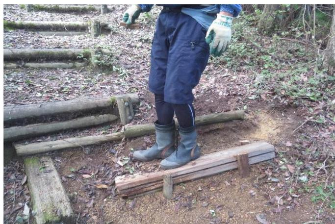
角材だけでは足を乗せる部分が狭かったので角材を少し離れた所に設置し溝を砂で埋めた。
