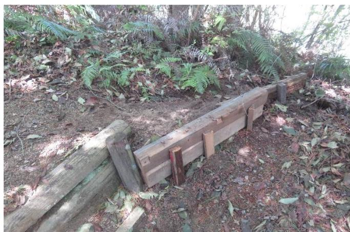
以前設置した角材。杭が出っ張っていたので躓かないよう手鋸で切断。
