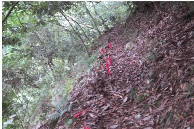
作業前の現場。杭を残して角材が谷へ落下してしまっている。
