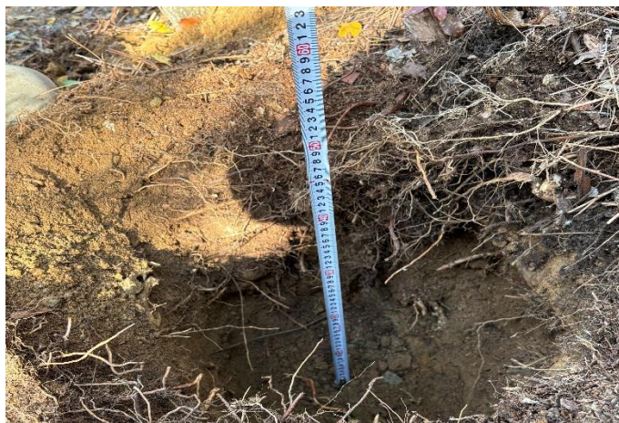
道標を設置するための深さ40cmの穴を掘るのは石や木の根のため思った以上に大変でした。
