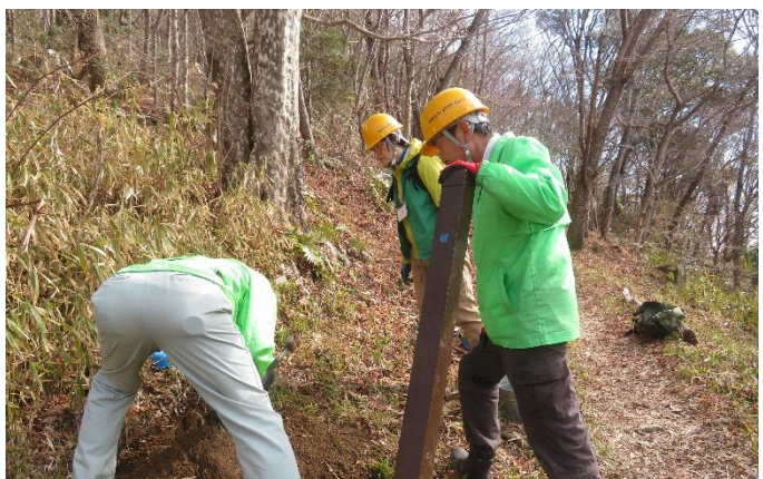
A チームの作業の様子② 支柱を埋めるのに邪魔な草を刈っています。
