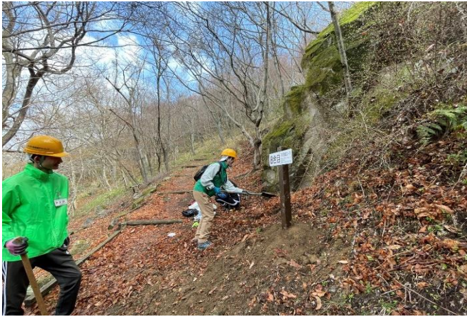
8合目道標の設置作業の様子。
