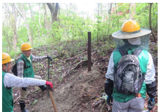
設置した七曲がり西コース7合目道標の支柱。 誰が言ったか「支柱だけだと墓標みたい」
