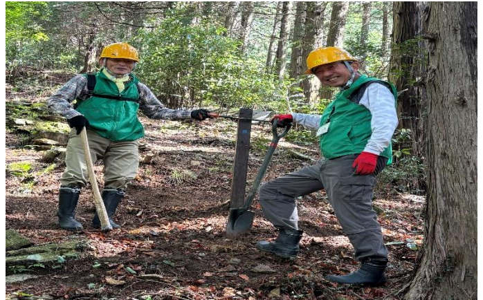
設置した七曲がり西コース8合目道標の支柱。 傾いて見えますがきちんと水平になっています。
