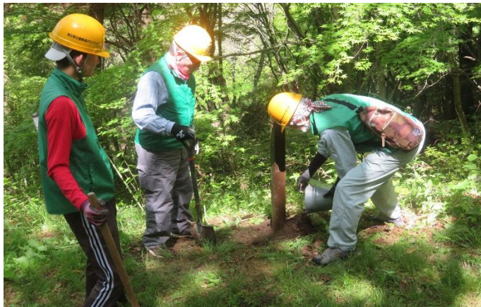
七曲がり東コース7合目道標の設置作業の様子。 目印が倒れていたのになかなか見つかりませんでした。
