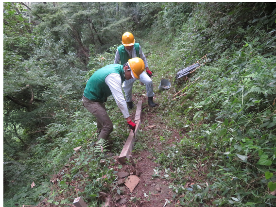
活動の様子④ 運んできた木材で崩れた路肩をいくつか補修しました。
