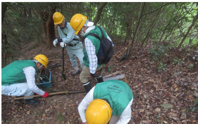
活動の様子② 負い子で持参した横木を設置しています。
