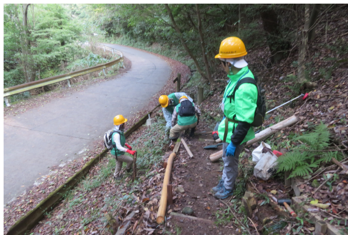
作業の様子①。路肩に角材を設置してますね。
