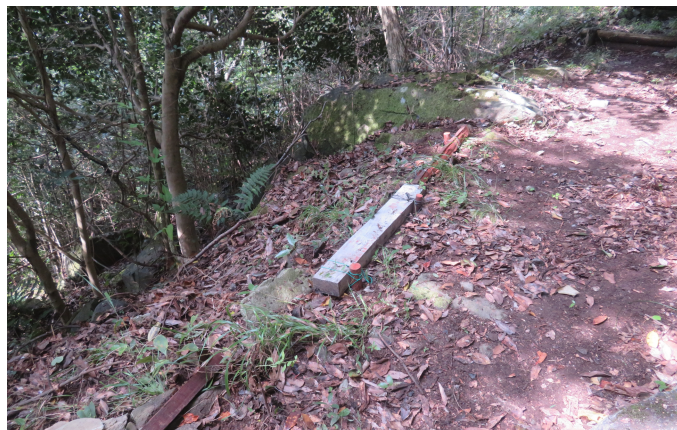
作業後の路肩。しっかり備え付けられていますね。
