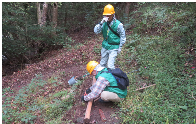
作業の様子③。こちらは丸太の設置作業です。
