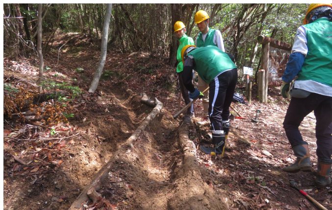
完成した水路。皆さんお疲れさまでした。
