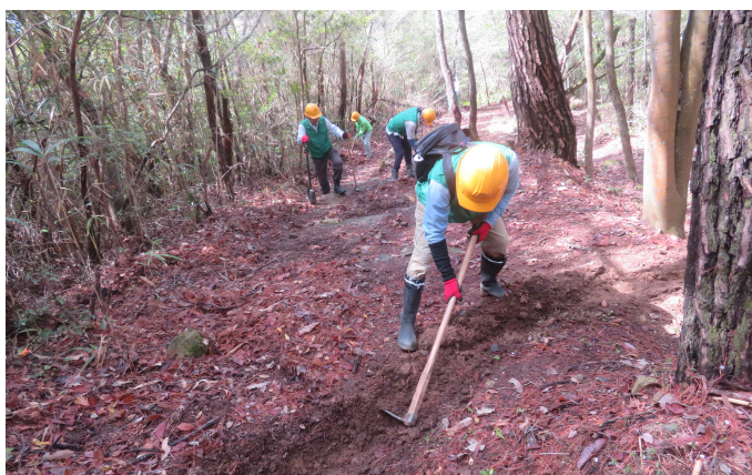
横断溝を掘る末永さん。横断溝のほとんどが水分を吸った土砂で埋まっていたので掘るのも大変でした。
