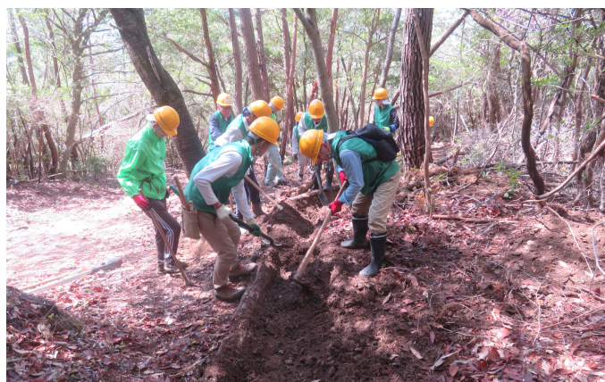
4号目の看板付近にて会員全員で水路を作成する様子①
