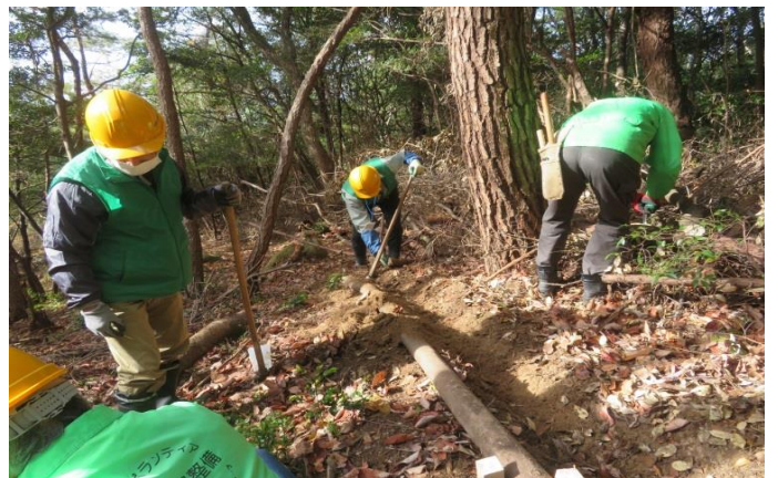
横断溝掘り込み作業中
