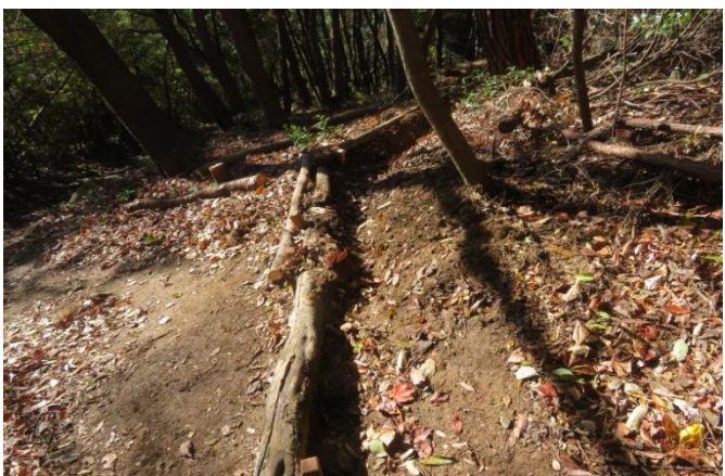
横断溝の掘り込み
