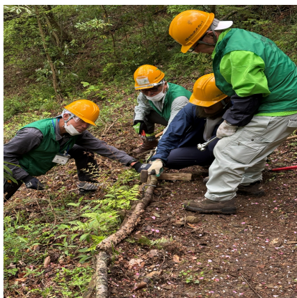
七曲りコースの路肩を整備する様子①
