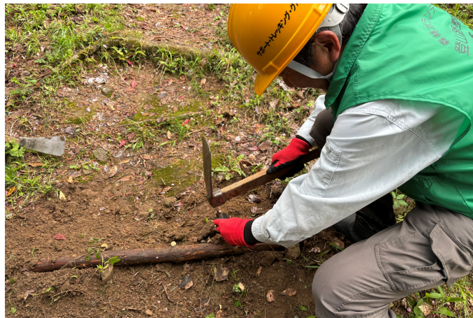
第二展望台周辺の登山路の階段部分を修復する様子①
