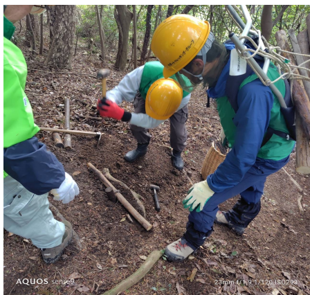
第二展望台周辺の登山路の階段部分を修復する様子②
