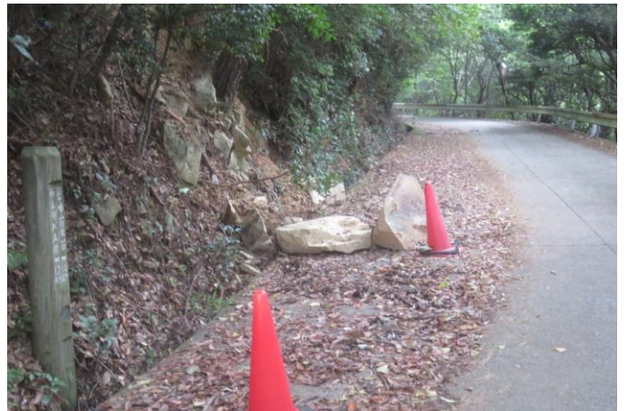
土砂崩れで斜面から道路へ流れ込んできた岩や落ち葉。ちょっとこのサイズは人力では運べませんね。
