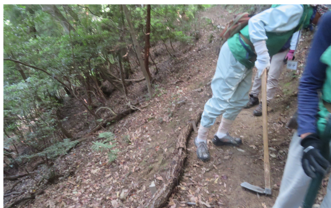
雨風で崩れた路肩を整備している様子③
