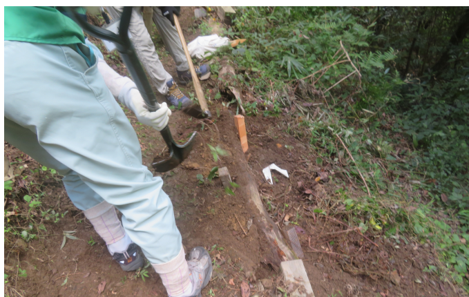
雨風で崩れた路肩を整備している様子②
