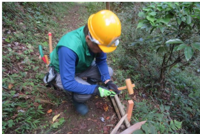
雨風で崩れた路肩を整備している様子①
